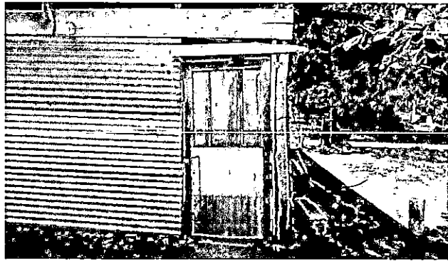
Foto 3: Sustitución de puerta
